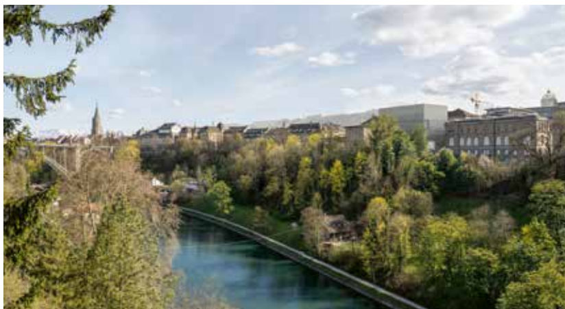
Der Blick von der Lorrainebrücke auf den Aarehang zeigt, dass der Neubau zu hoch geraten ist. An der Hodlerstrasse liegen die bestehenden Bauten im Gegensatz zur parallel verlaufenden Speichergasse ein Geschoss tiefer. Visualisierung.
